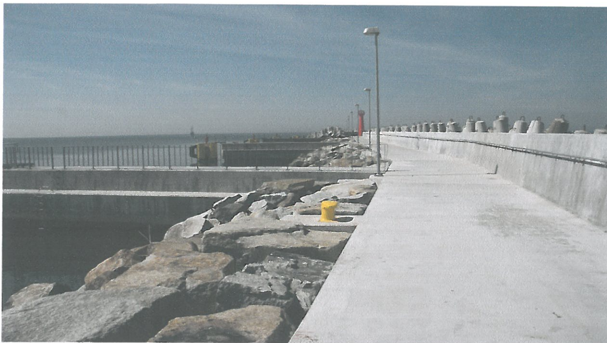
Fot. 5: odcinek nowego falochronu wschodniego w Kołobrzegu; 10.05.2011 r. autor: mgr inż. Adam Szymański
