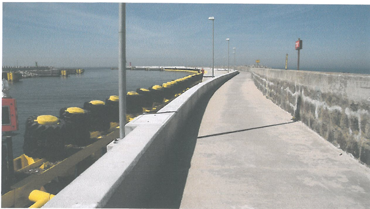
Fot. 3: odcinek starego falochronu wschodniego w Kołobrzegu; 10.05.2011 r. autor: mgr inż. Adam Szymański
