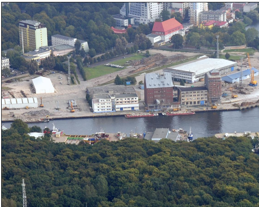
Fot. 1. Teren Nabrzeża Zbożowego w Kołobrzegu
